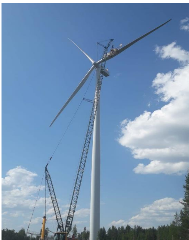
Piiparinmäki Construction Site Visit, 2022
